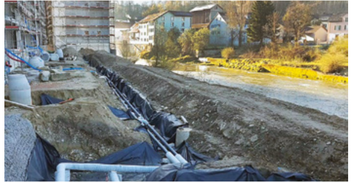
Leitungsbau Überbauung «Bruggmühle» (Bild: TGB).
