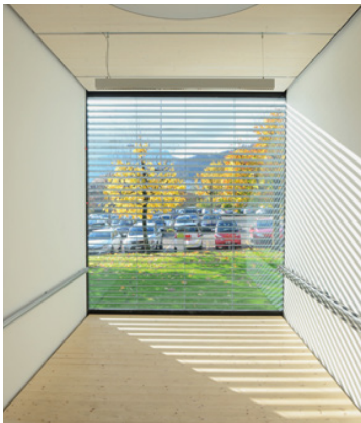
Innenansicht des LichtMessContainers auf dem Campus der Hochschule Luzern Technik & Architektur (Foto: Björn Schrader).
