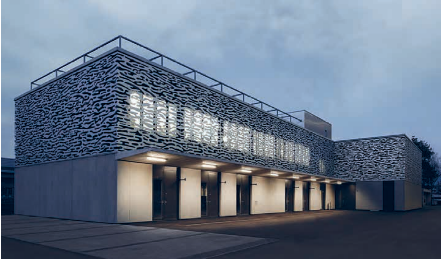
Die vorgehängte Fassade aus Aluminiumblech dient auch als fixer Sonnenschutz: Neubau Eawag-Forschungsgebäude Aquatikum in Dübendorf (Foto: Andreas Müller Architekten AG, Patrik Fuchs).
