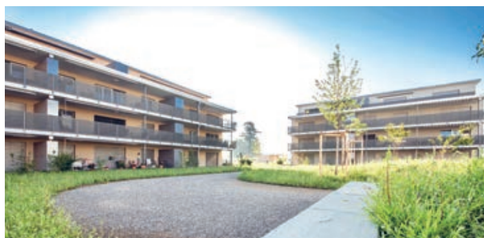
Die Minergie-P-Überbauung (Foto: Patrick Moehle, Stein a. Rhein).
