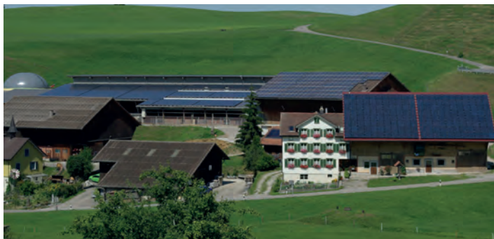
Der Plus-Energie-Hof in Fischingen.
