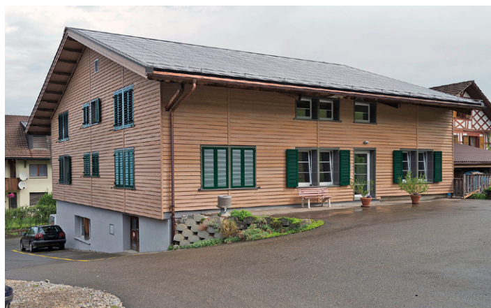
Wie neu: Das Minergie-P-Mehrfamilienhaus in Hüttlingen nach der Gesamtanierung. (Foto Gerber Verlag)
