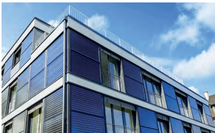
Die thermischen Sonnenkollektoren kleiden die Fassade ein. (Foto: E+H Ingenieurbüro für Energie + Haustechnik AG)
