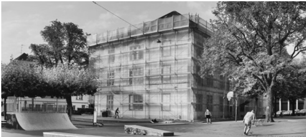
Im Kanton Schaffhausen stehen vorderhand nur Fördergelder für Gebäudehüllensanierungen aus dem nationalen Gebäudeprogramm zur Verfügung (Foto: Michael Kovacs, Basel).
