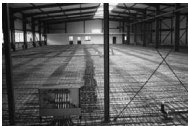
Als Pufferspeicher – hier im Bau – dient die Bodenplatte der Produktionshalle.
