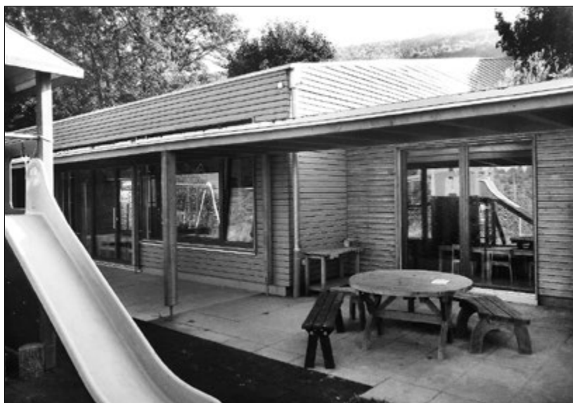
Der Hinterausgang des Doppelkindergartens führt ebenerdig zum Spielplatzbereich (Bild Felix Meyer).
