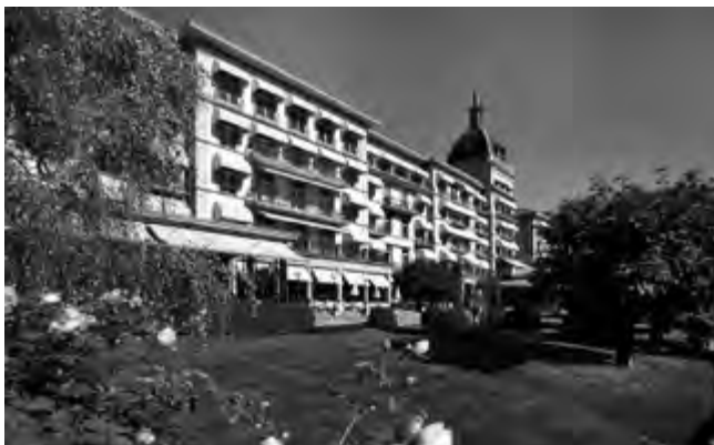
Abbildung 5: Gleichzeitige Wärme- und Kältenutzung im Hotel Victoria Jungfrau.
