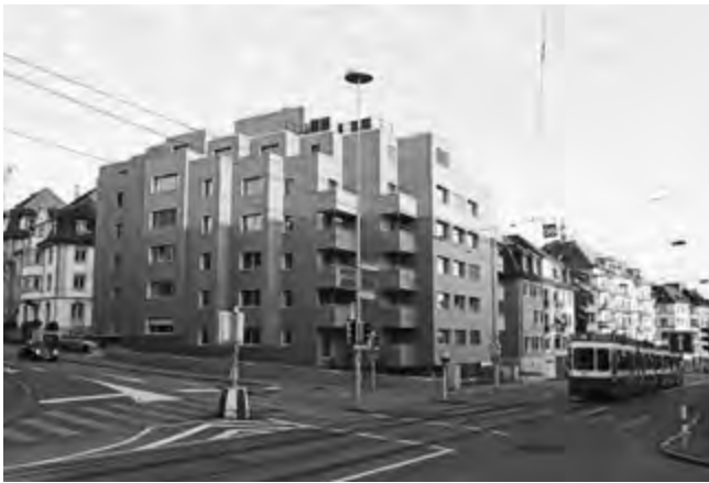
Abbildung 1: Das Wohnhaus in Zürich-Unterstrass nach Sanierung und Einkleidung mit einer Photovoltaikfassade.
