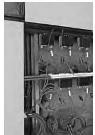
Abbildung 2: Mit einem Leistungsoptimierer erkennt der Wechselrichter mögliche Leistungsverluste bei Fassadenverschattung.
