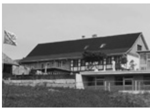
Die erste Solarstrom-Indachanlage in Amlikon-Bissegg.
