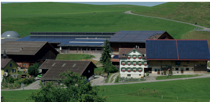
Der Plus-Energie-Hof in Fischingen.
